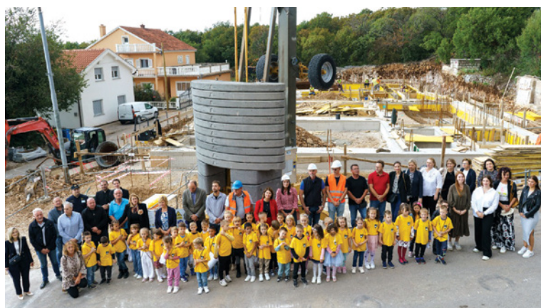
Svečano obilježen početak radova izgradnje novog dječjeg vrtića u Crikvenici
